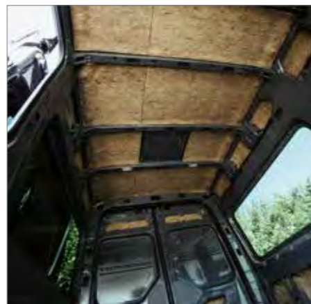
Deckenisolierung mit Schafswolle
