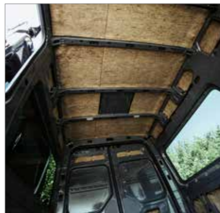
Deckenisolierung mit Schafswolle
